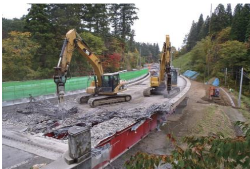
＜土木工事の様子＞
