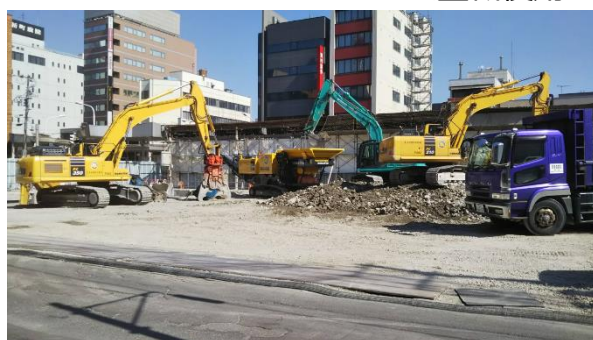
＜重機使用の様子＞
