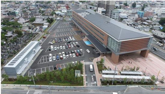
深谷市役所建設工事
