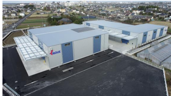
物流倉庫建設工事
