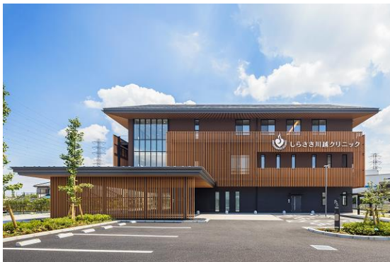
クリニック建設工事
