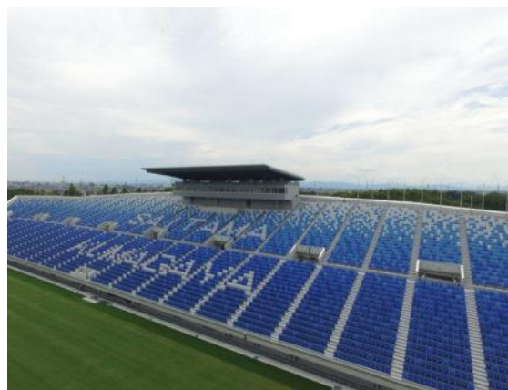
スタジアム外部改修工事
