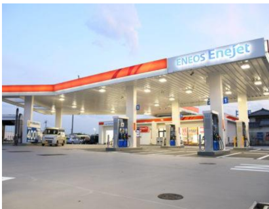
ガソリンスタンド再生改造工事
