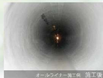
オールライナー施工例 施工後
