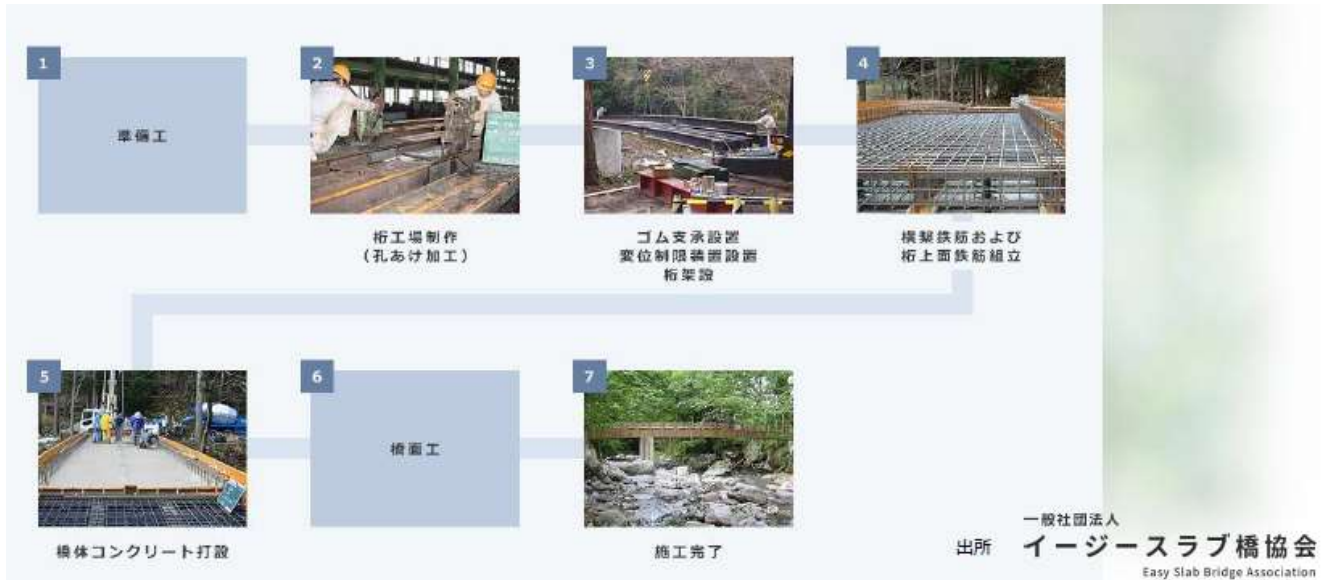
図9 イージースラブ 施工フロー
