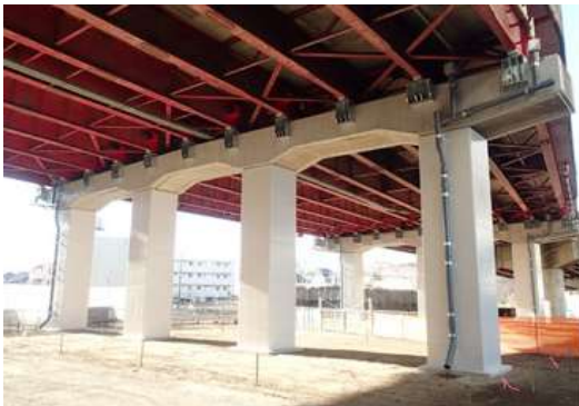
埼玉県入間市 橋脚補強工事
