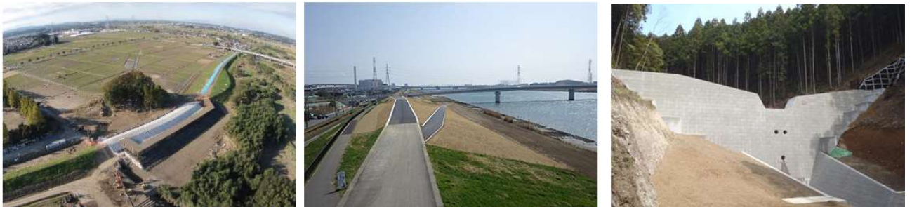
左図より 埼玉県東松山市 台風19号復旧工事 千葉県市川市 高谷高潮堤防工事 埼玉県比企郡ときがわ町 砂防（えん堤）工事
