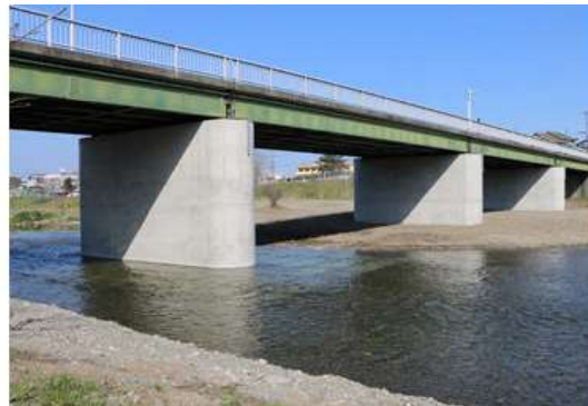
埼玉県入間市 橋脚耐震補強工事
