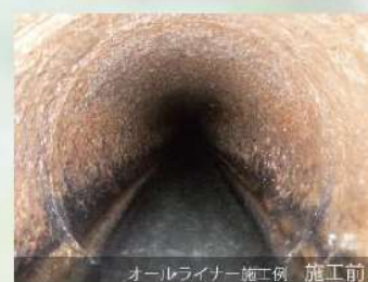
オールライナー施工例 施工前
