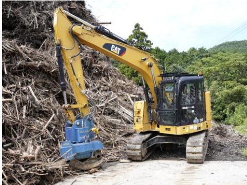
0.45 バックホー（グラブ装置付）3 台
