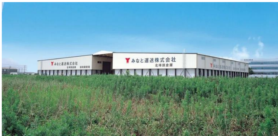
北埠頭倉庫の外観
