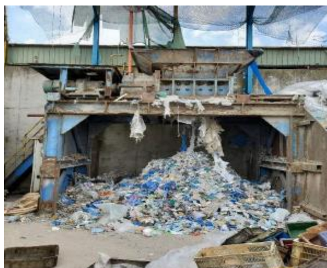
破碎処理施設の様子
