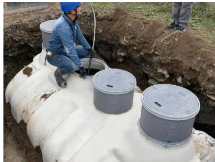
浄化槽設備工事
