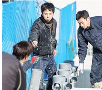
給水排水工事
