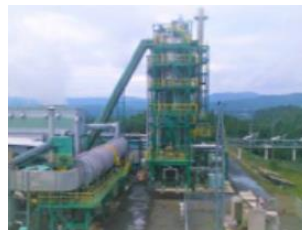
バイオマス発電所
