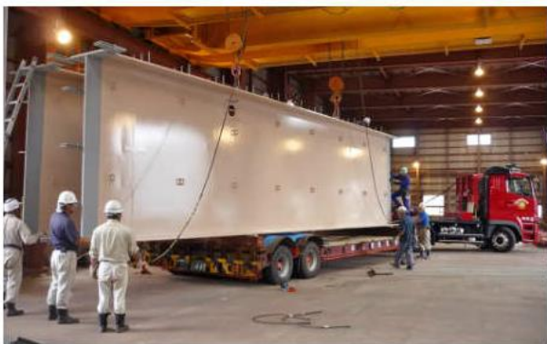
橋桁 16輪低床トレーラー
