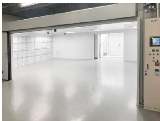
2023年5月 エアバス・ヘリコプターズ・ジャパン株式会社へ納品した空調機能付き塗装ブース『CAB-H2』
