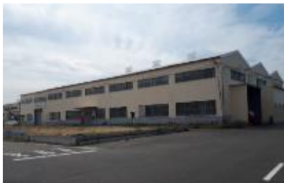
食品残渣の廃棄物処理工場 (住吉工場内)
