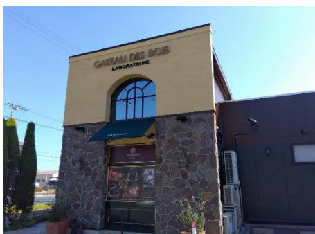
店舗外壁塗装工事
