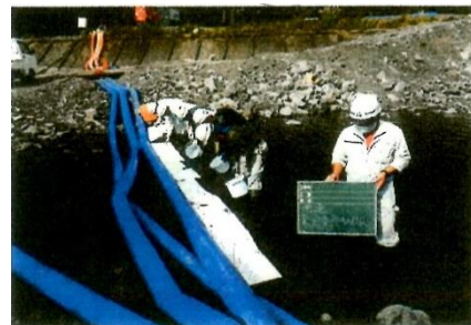
河川工事現場での環境緊急事態対応訓練
