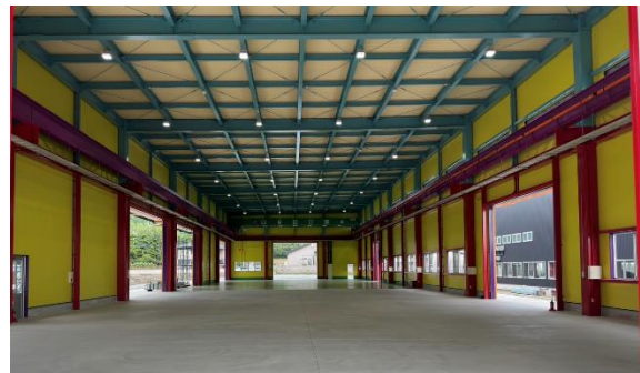
写真⑩ 新設した第3工場内観（出田産業提供）
