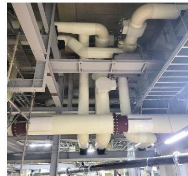
写真⑦ ももち熱源センターで施工した配管設備（出田産業提供）
