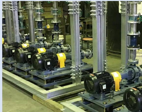
(機械器具設置工事)
