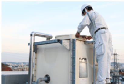
設備メンテナンス(給水装置)
