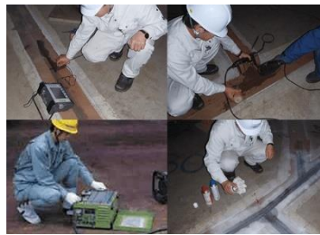
非破壊検査 (タンク等構造物) (出所) ナカテック HP より
