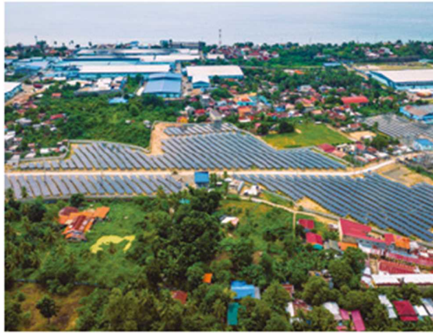
セブミツミ工場の太陽光発電システム
