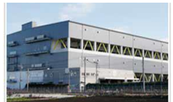
八王子配送センター
