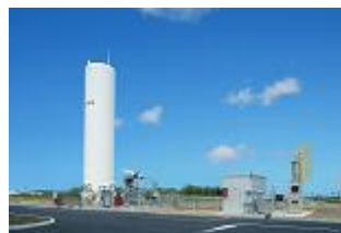
<ガスサテライト(輪厚工場)>
