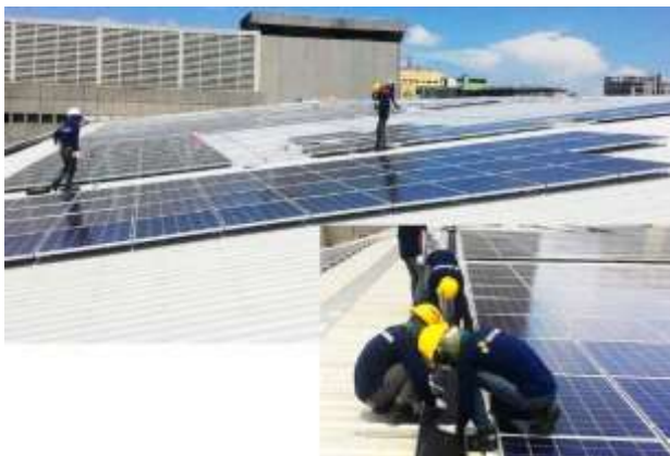
太陽光発電所の施工
