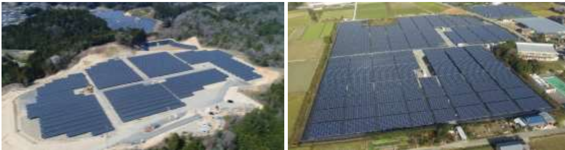
三重県伊賀市(写真左、合計 2.8MW)と愛知県知多郡美浜町(写真右、合計 4.5MW)の大規模太陽光発電所
