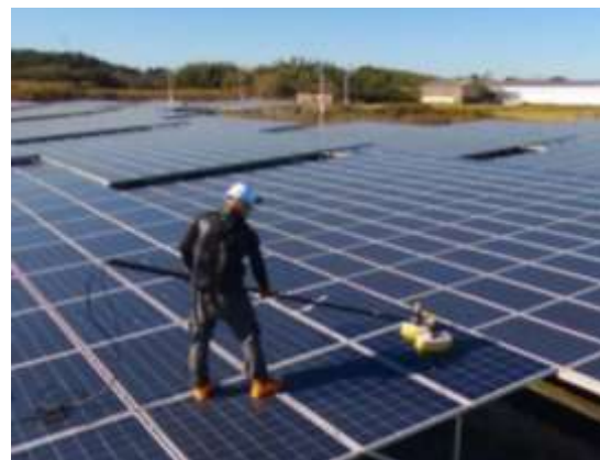
太陽光発電所のメンテナンス
