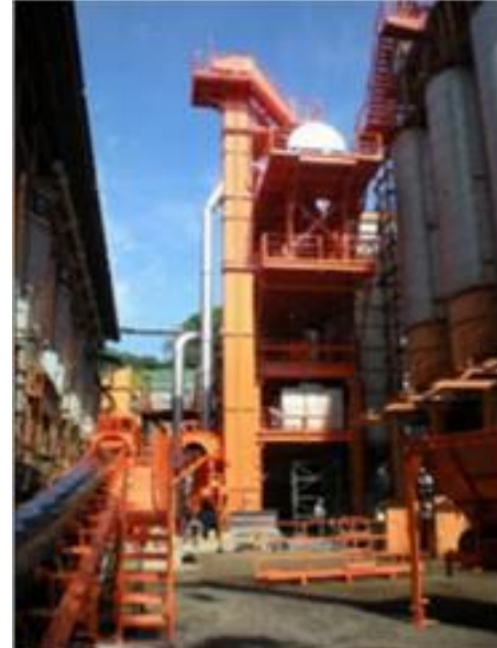
(リサイクルユニット)
