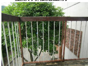
塗膜剥離施工前
