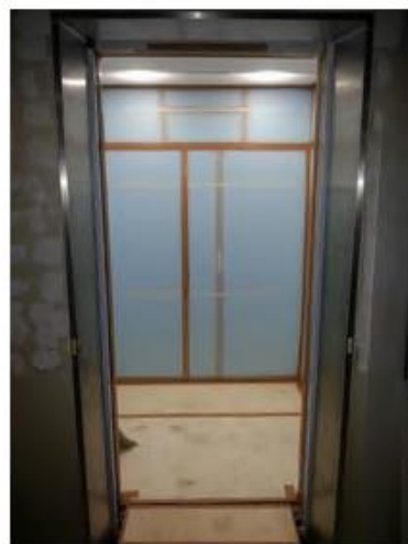
養生工事施工後
