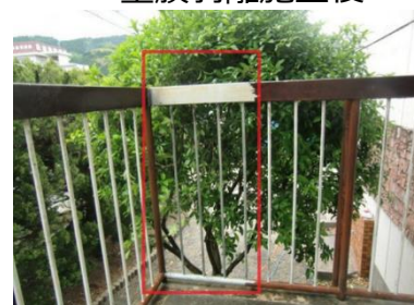
塗膜剥離施工後
