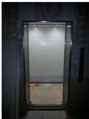
養生工事施工前
