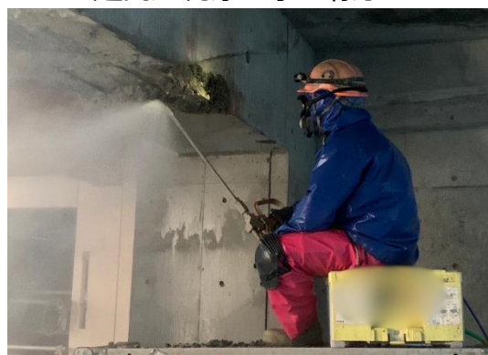
超高压洗浄工事の様子
