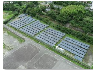
太陽光発電システム(那智勝浦町)
