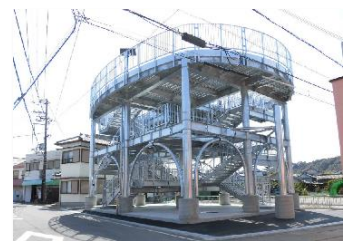
下里津波避難タワー整備工事
