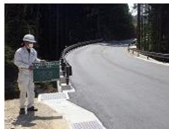
国道 371 号道路改良工事
