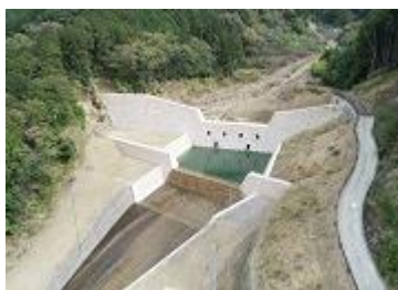
那智川平野川他流域整備工事
