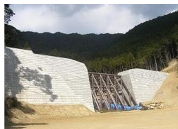
那智川樋口川地区2号堰堤工事
