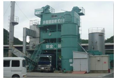
アスファルトコンクリート製造プラント
