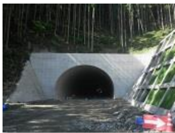
那智勝浦道路竹向地区トンネル工事
