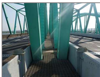
東名阪自動車道木曾川橋
