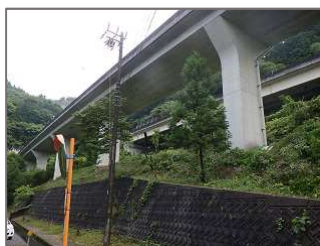
伊勢自動車道多気高架橋
