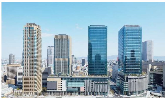
グランフロント大阪（大阪本社）
