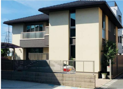
(施工実績の一例)
