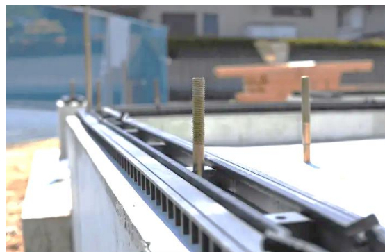
基礎パッキン(木製土台設置前)
