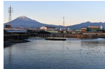
②潤井川河口沈砂池
