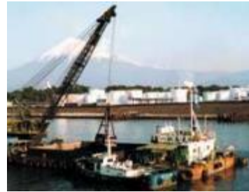
①起重機船を用いた浚渫
