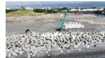
④海岸保全工事
