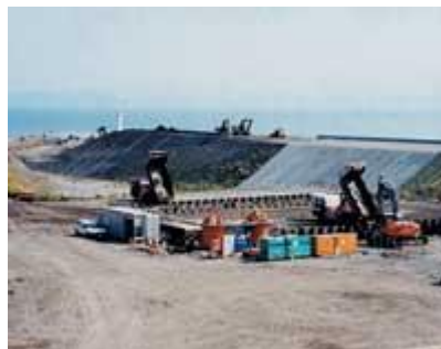
脱水ケーキを用いた埋立て
