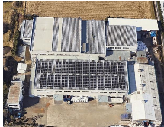
＜マリーナ工場屋根の太陽光設備＞
