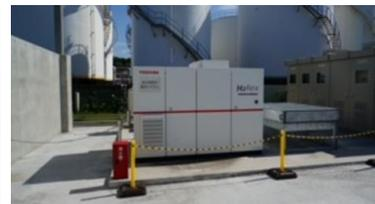
純水素型燃料電池システム
