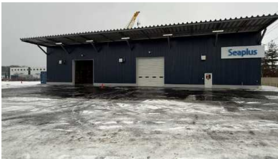
図表 1 シープラスの北海道恵庭市戸磯の新倉庫
