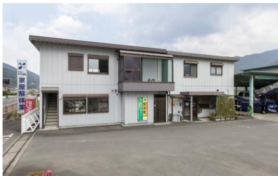
写真④ (有)ヤマト重機本社 出典：当社提供
