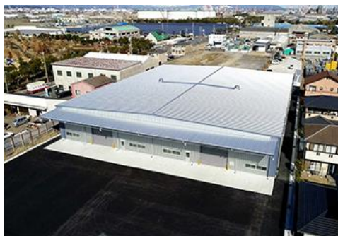
2022年2月完成の物流用新倉庫
