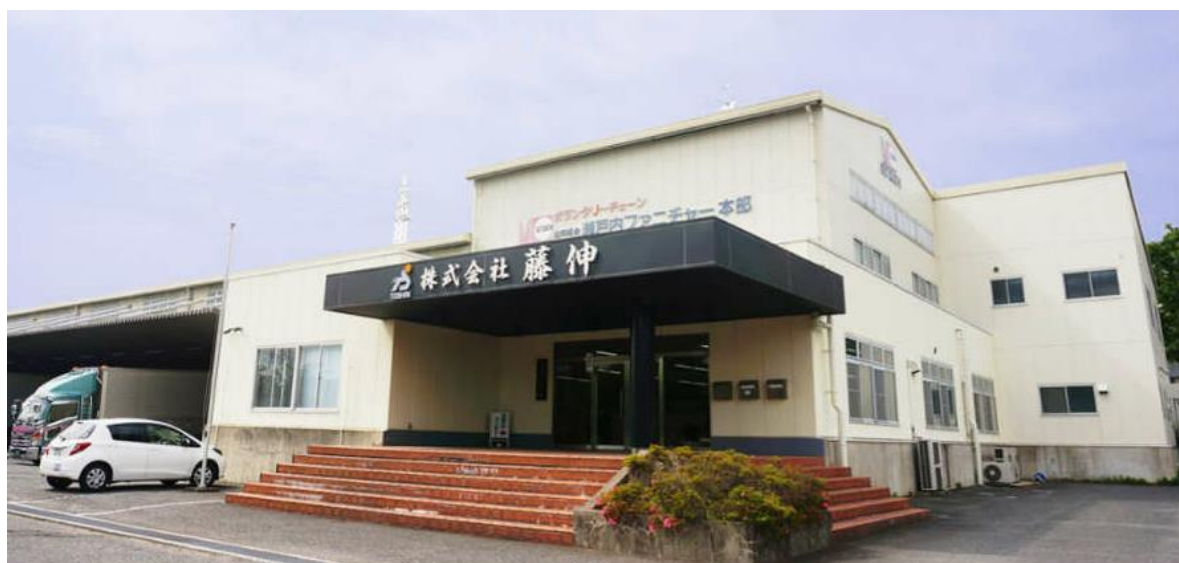
写真③ 岡山営業所（出典：藤伸 web サイトより）
