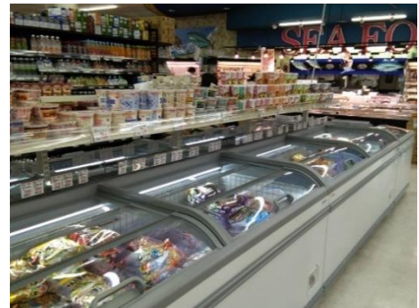
写真⑭ ノンフロン冷凍ショーケース （出典：コノミヤ提供）
