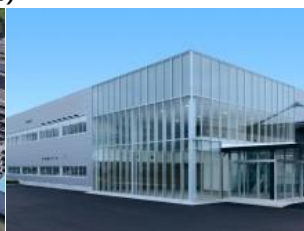
プラスチック代替製品 製造工場建設工事
