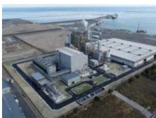
苅田バイオマス発電所 電気計装工事
