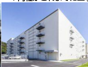
京セラ第20工場幹線敷 設工事
