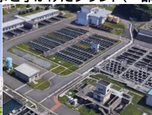
中央監視制御設備更新 電気計装工事
