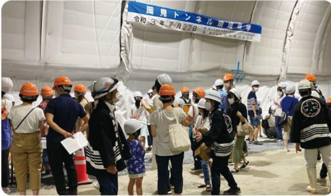
地域住民を対象にした現場見学会（島根県 三隅岡見トンネル工事所）
