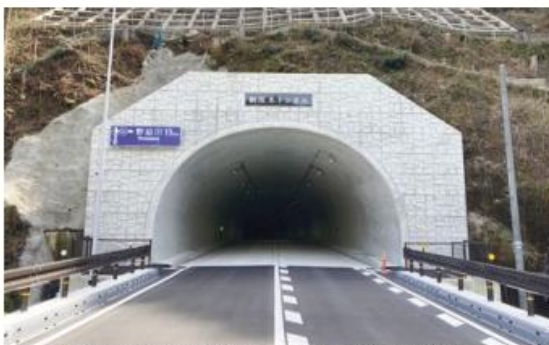
道路：一般国道168号 阪本工区(仮称) 阪本トンネル工事(奈良県五條市)
