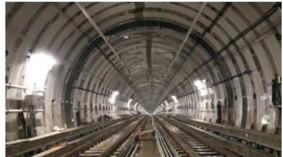
鉄道：相鉄・東急直通線、新横浜トンネル(横浜市港北区)
