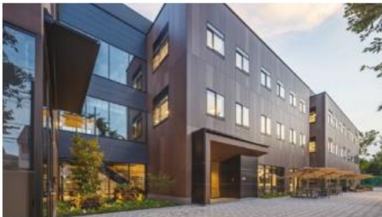
教育施設：辻調理学館専修学校 東京(東京都小金井市)
