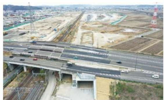
鉄道：仙台貨物ターミナル駅移転に伴う函渠新設工事(仙台市宮城野区)
