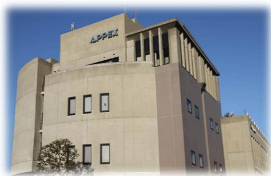
市川プロダクションセンター
