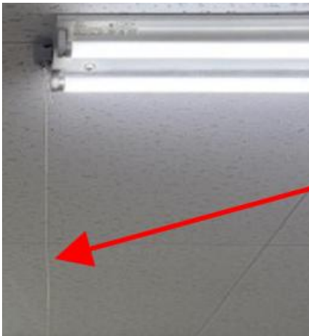
（写真⑧）個別スイッチ（ひもスイッチ）を付けた照明 （坂井電機提供）
