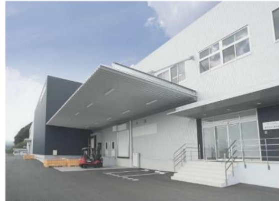
株式会社 高知道水 高知県宿毛市坂ノ下字石窓山1023番地31
