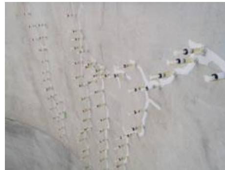
a.ひび割れ注入工
