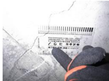
a.ひび割れ注入工
