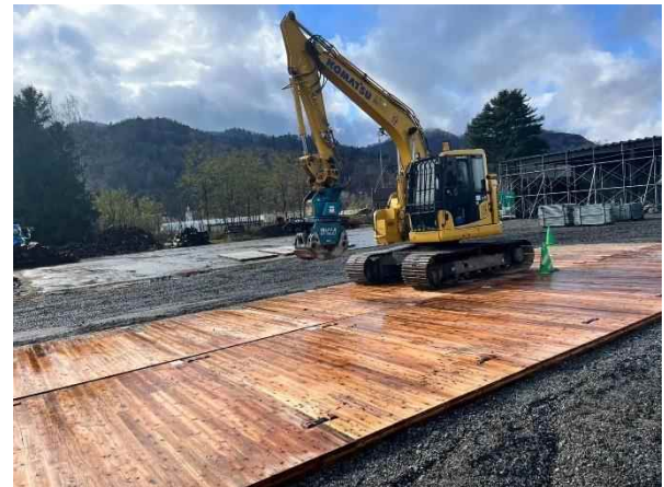
写真：「CLTmat」の走行耐久試験の様子 (出所) 株式会社イトイグループホールディングス
