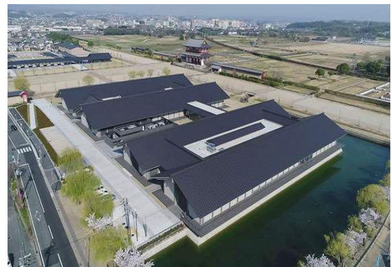
写真⑱施工例「公共施設」（当社提供）
