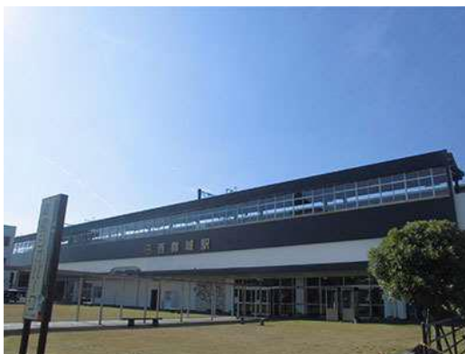
写真⑰施工例「鉄道施設」（当社提供）
