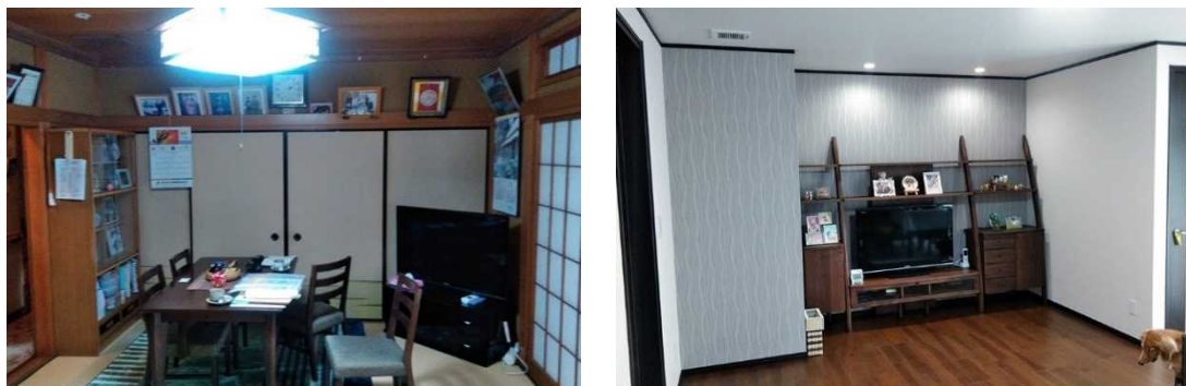
図表 8. リフォーム工事の一例（左が工事前、右が工事後）
