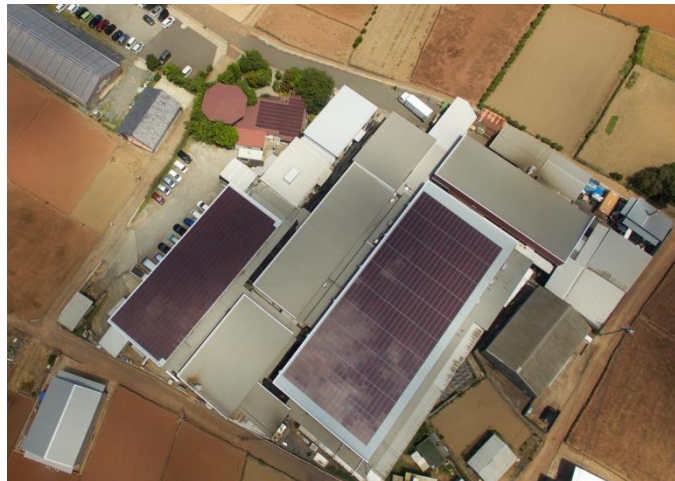
〈愛野センターの屋根に設置の太陽光発電設備 出典：同社より〉
