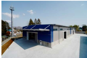
左：本社と第一倉庫 右：第三倉庫 (当社提供)
