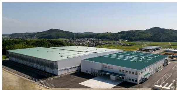
ホクト(株)三重きのこセンター新築工事
