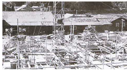
松阪商工会議所の新築工事風景
