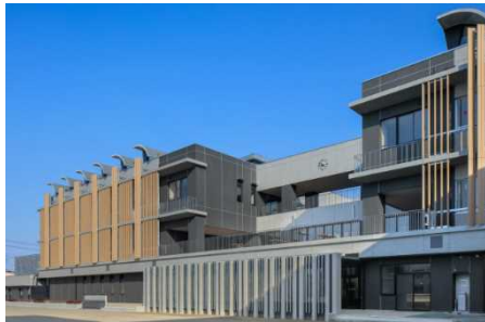
松阪市立鎌田中学校校舎改築工事
