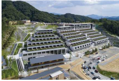
ホテル ヴィソン新築工事【VISON】
