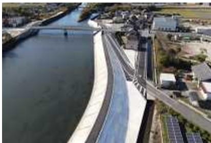
二級河川三渡川河川改修(旧堤撤去)工事
