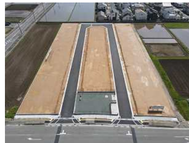
玉城町佐田宅地造成工事
