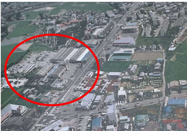
1996年 新築の現本社（埼玉県熊谷市広瀬）
