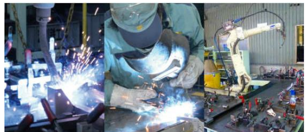
(写真②) 溶接作業の様子 (淀川鐵工提供)
