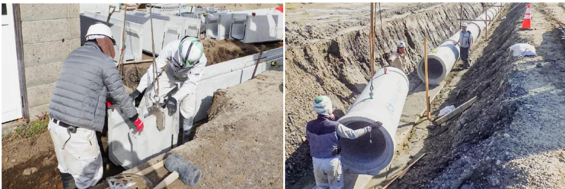
公共工事の施工
